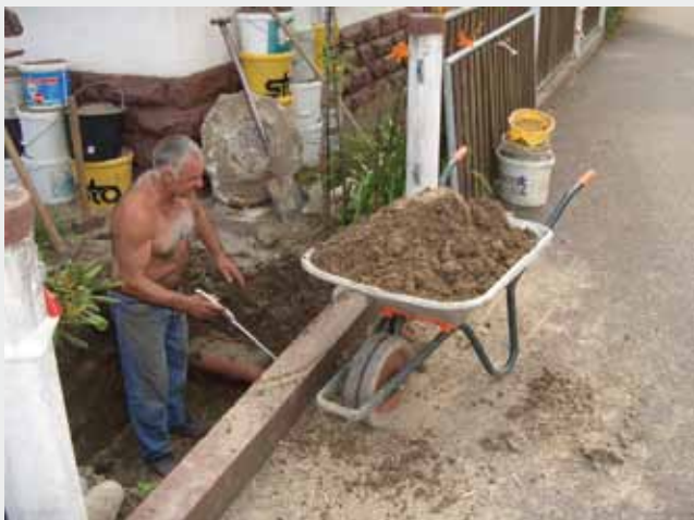
Offene Bauweise (hier in Eigenleistung)
