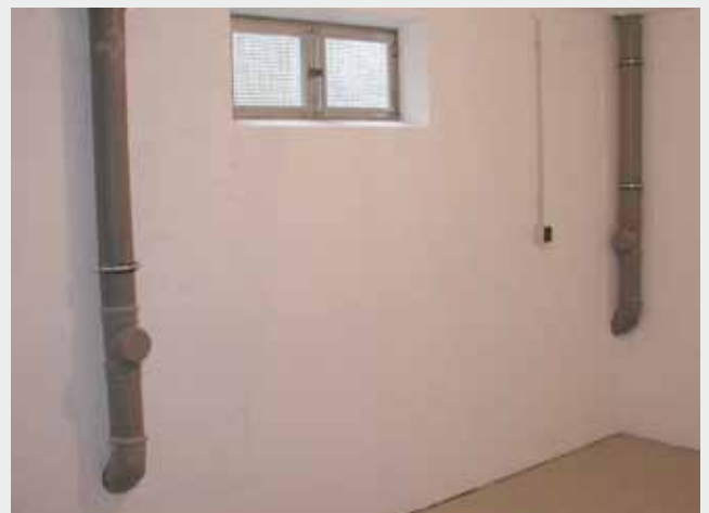
Umbau der Hausinstallation – abgehangte Leitungen
